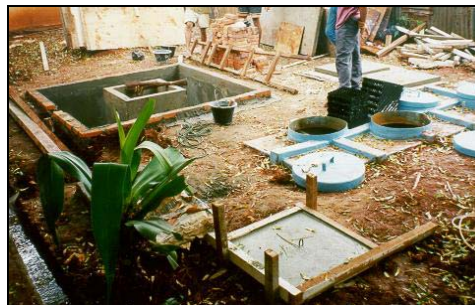
Gambar 7 : Pembangunan IPAL di Dalam Tanah
