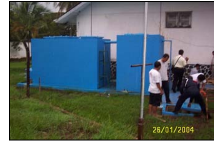
Gambar 8 : Pembangunan IPAL di Atas Tanah
